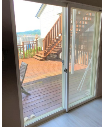
既存窓の内側に取付
